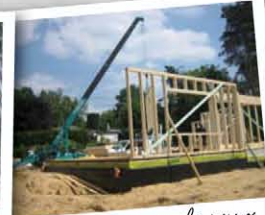
Монтаж деревянных конструкций
